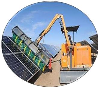
Cuidado ao utilizar equipamentos de limpeza que exerçam contato direto e pressões excessivas nas superfícies do produto, pois podem ocasionar danos ao módulo. Estes danos vão desde riscos nos vidros causado pelo efeito de abrasividade, até o comprometimento dos componentes do módulo, incluindo trincas e microfissuras nas células fotovoltaicas.
